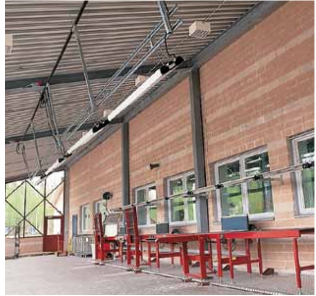
Для наилучшего эффекта приборы лучше располагать не над головой, а с некоторым смещением, для того, чтобы большая часть излучения поглощалась телом человека. В данном случае для равномерного распределения тепла с одной стороны под балками перекрытия размещены приборы IR, а с другой, на стене здания обогреватели CIR.
